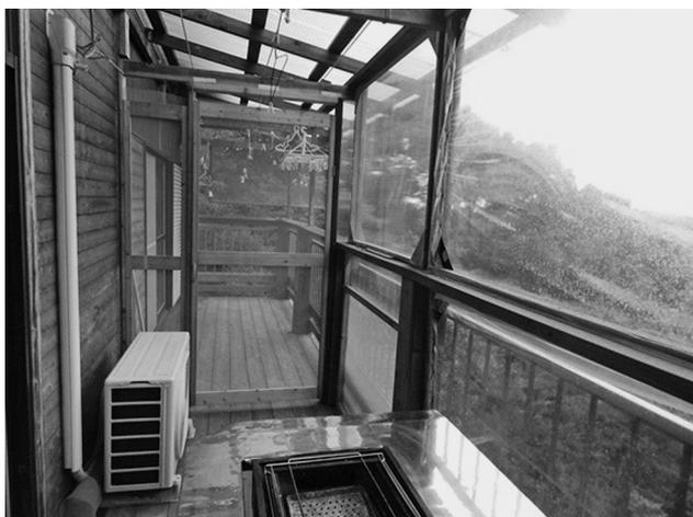
ベランダの屋根工事の前に壁面にはサイディングを施しています。
